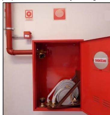
Figura 56: Detalhe de hidrante.
