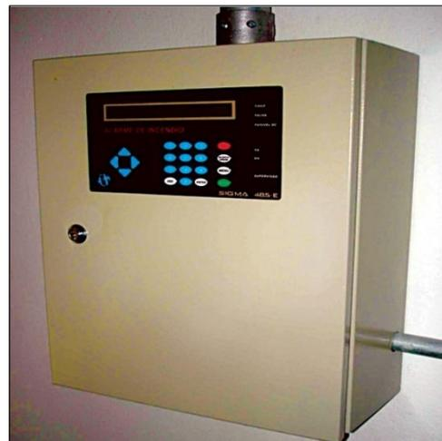
Figura 51: Central de alarme de incêndio.
