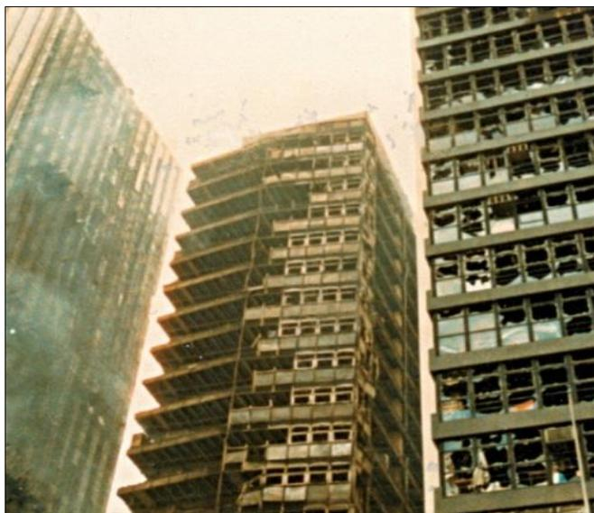
**Figura 22:** Radiação de calor de um edifício para outro.
