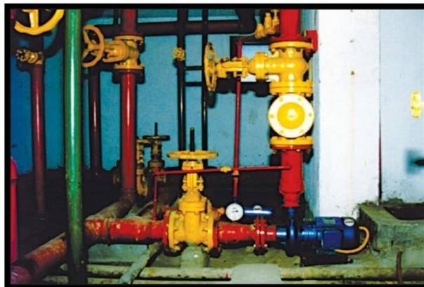
Figura 57: Bomba de incêndio e acessórios hidráulicos.
